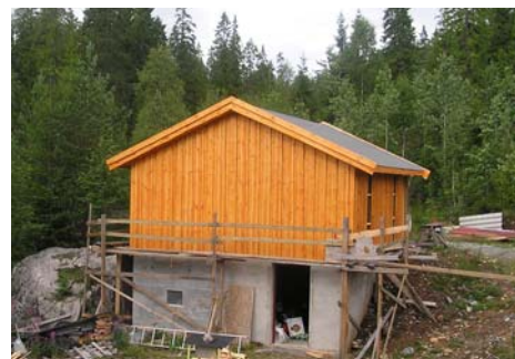
Bygget er oppe, i samme stil som stua. Dette bildet er fra sist i juli.
